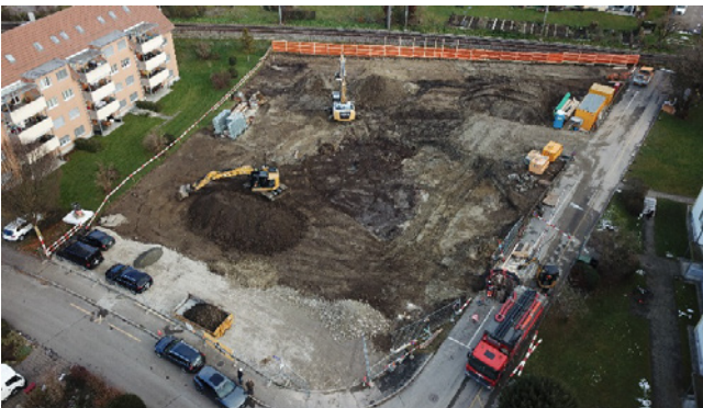
Grâce à cette implication des différentes parties prenantes, les travaux de construction se sont déroulés de manière optimale.
